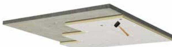
3 Fixer mécaniquement les panneaux à l'aide de chevilles (2 fixations par panneaux de dimensions 1 200 x 600 mm disposées en diagonal.) : • Pour les corps creux, utiliser des chevilles visant ce type de support • Pour les corps pleins, utiliser des chevilles visant ce type de support
