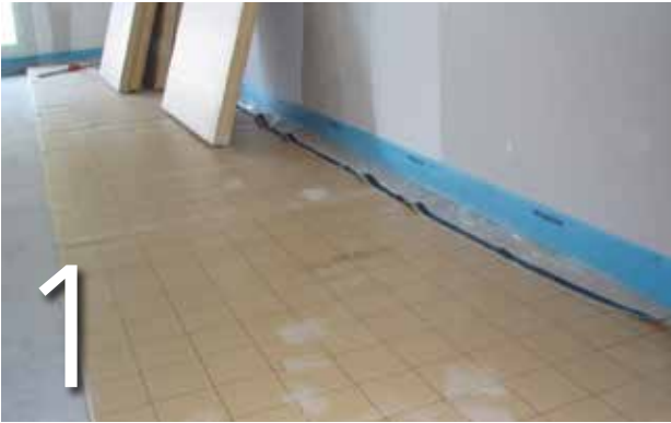
1 Placez l'IKOfix XPE sur le pourtour avant de poser les panneaux d'isolation IKO enertherm CHAPE.
