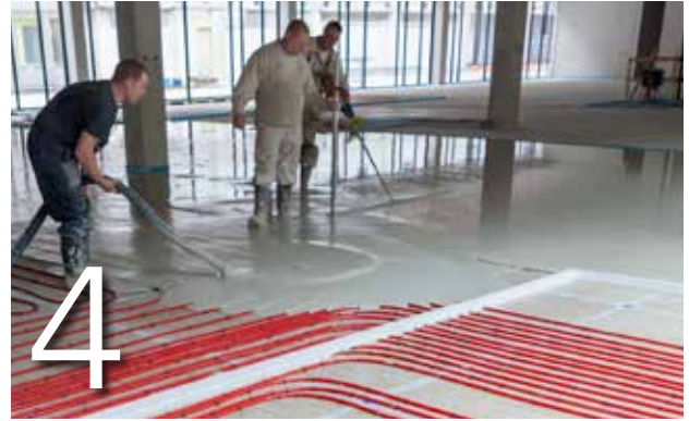
4 Appliquez la finition de sol (chapes, dalles désolidarisées ou flottantes...).
