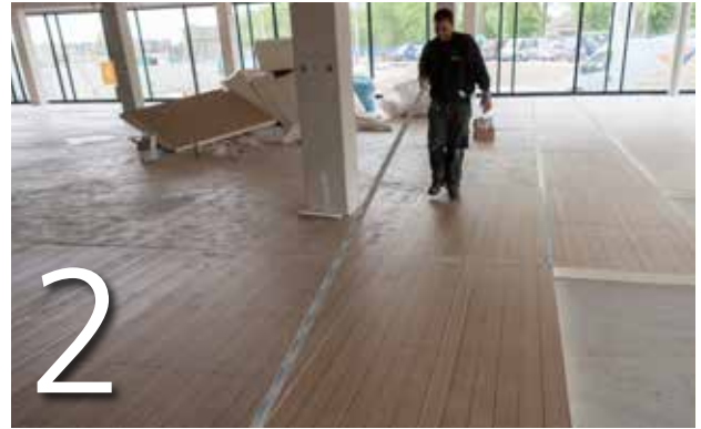
2 Les panneaux sont mis en place en partant d'un angle du mur opposé à l'entrée de la pièce, feuilures apparentes vers l'intérieur de la pièce et feuilures non visibles arasées le long des murs, de façon à présenter un bord droit en appui sur la bande périphérique. Les derniers panneaux aux extrémités sont coupés 3 à 5 mm plus larges et emboîtés en force.
