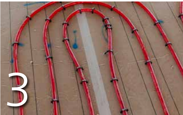
3 Appliquez les flexibles du chauffage par le sol à l'aide de l'agrafeuse et d'agrafes IKOFIX.
