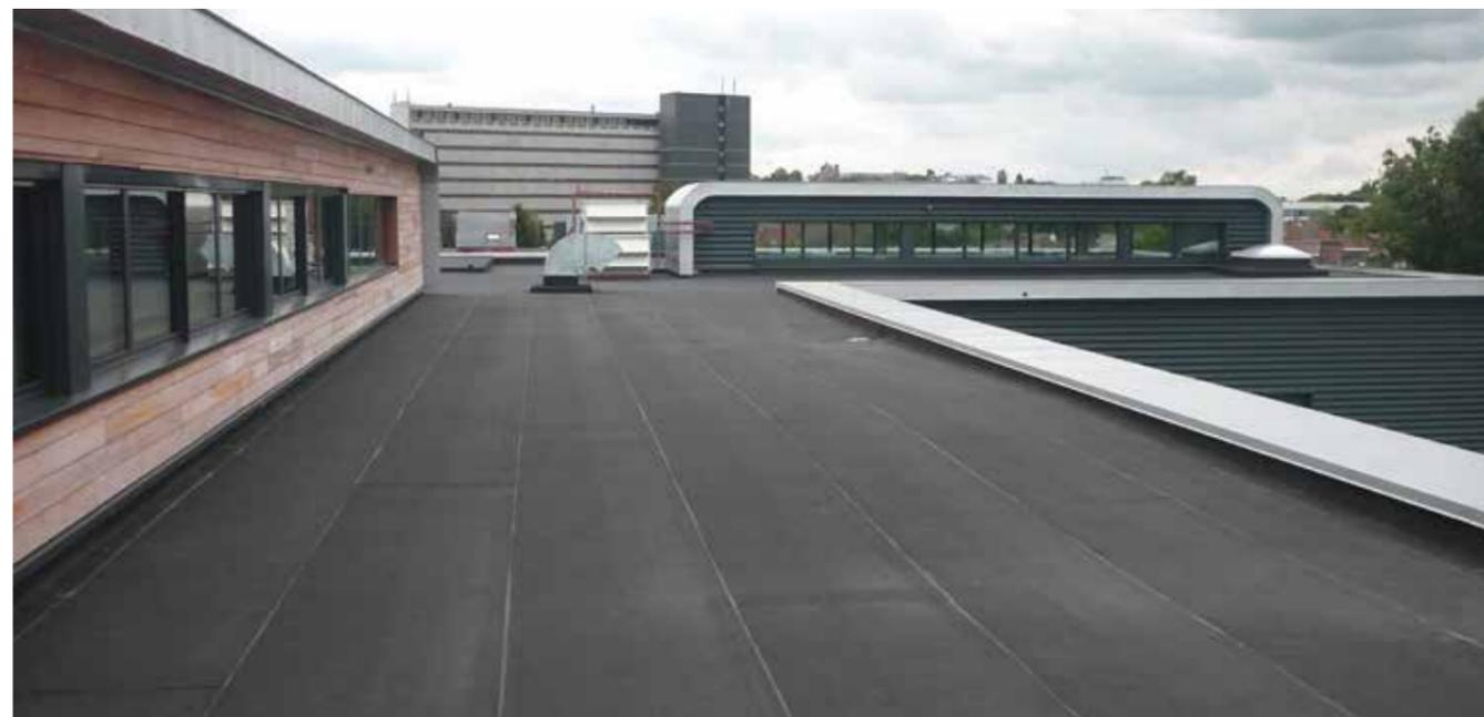
Pour donner à votre couche supérieure une base solide et étanche, faites votre choix dans notre large assortiment de sous-couches de qualité. Le choix dépend de la structure de la toiture ainsi que de la méthode de placement : soudage à la flamme, fixation mécanique ou collage.
