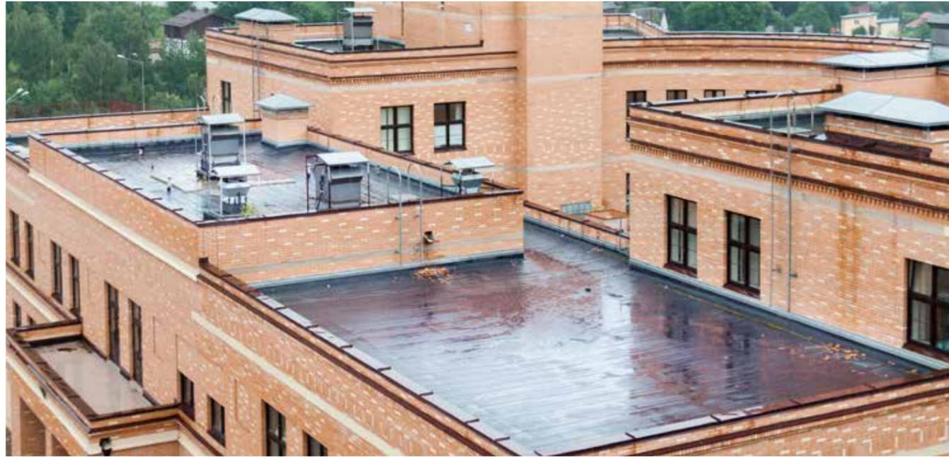
De plus en plus fréquentes, les précipitations extrêmes engendrent une surcharge hydrique. Sur un toit à rétention, les eaux pluviales sont stockées temporairement puis évacuées graduellement afin d'éviter le débordement de l'égouttage. Pour ce type d'application, IKO recommande une toiture compacte. La structure, entièrement fermée, offre une solution idéale pour la toiture à rétention IKO. Gérez votre eau sans vous inquiéter du risque de fuite.
