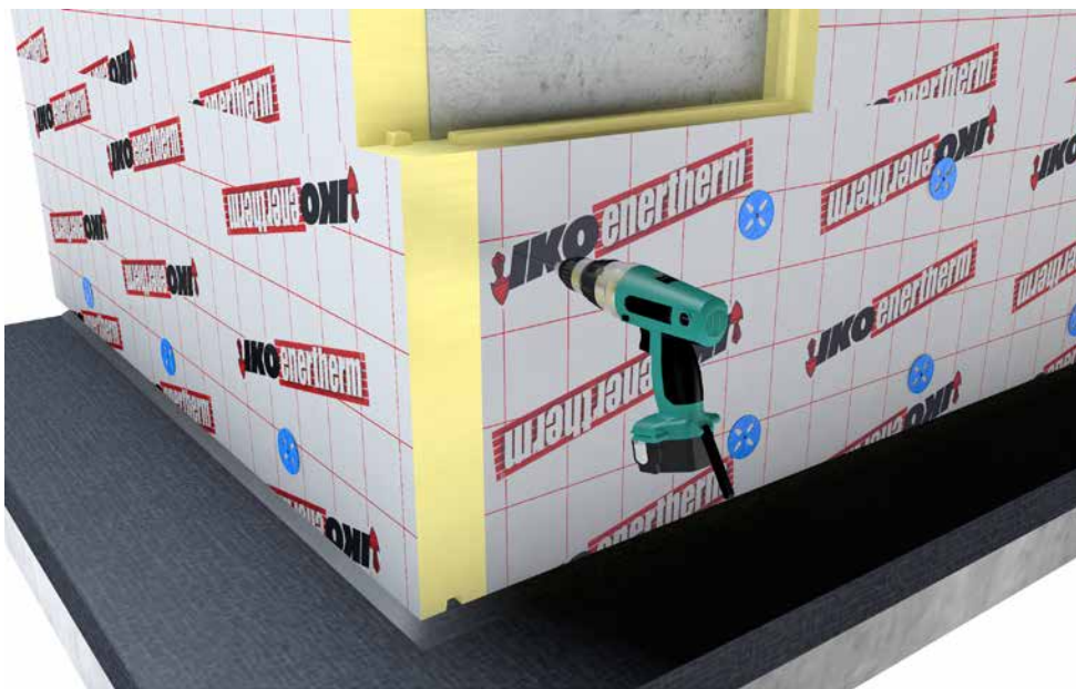
Perçage d'un trou pour la fixation de la cheville d'ancrage
